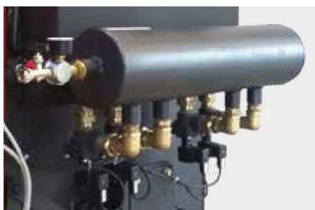
Nettoyage pneumatique des tubes de fumée
